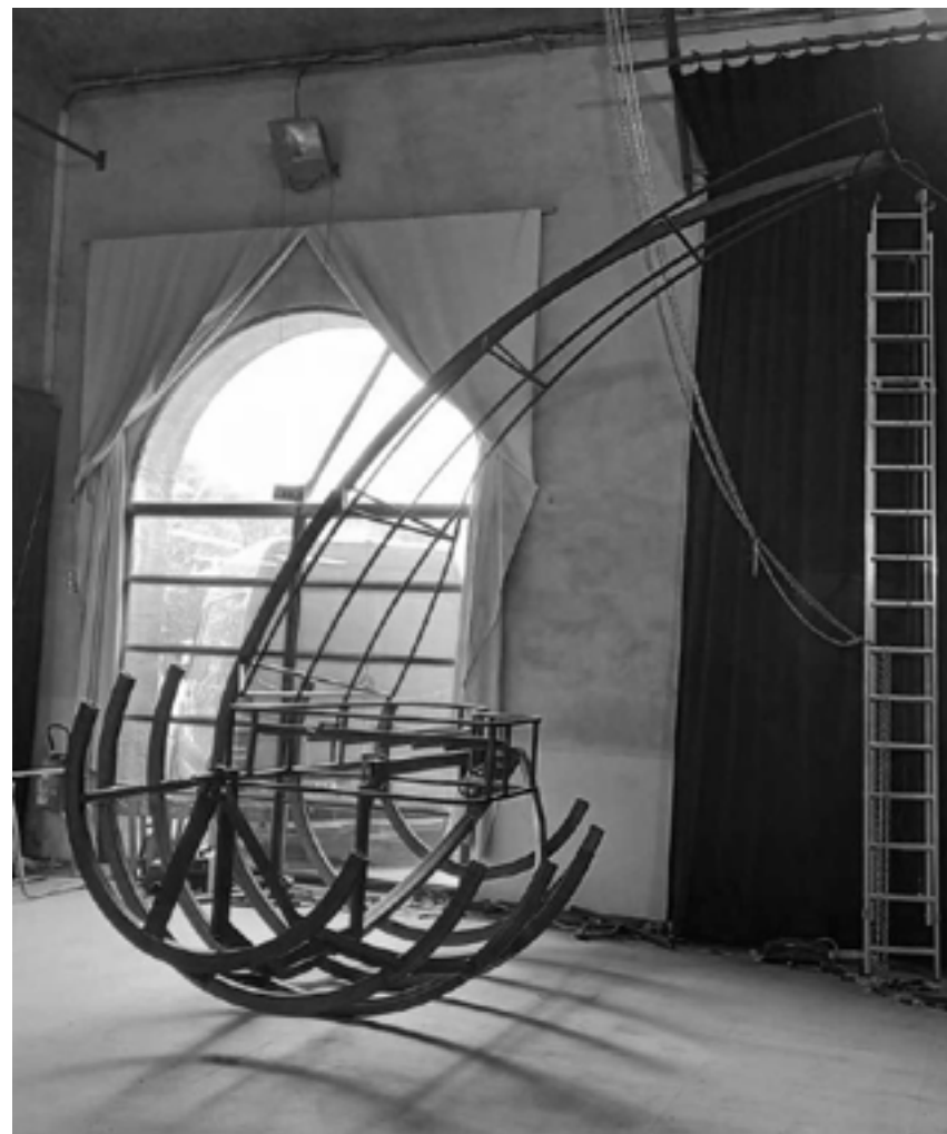
Structure en cours de construction Neil Price Mars 2022
