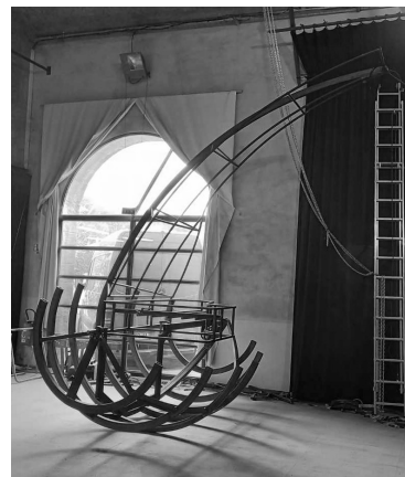
Structure en cours de construction mars 2022
